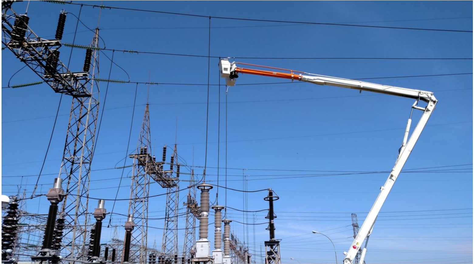
Reparo em subestações 230kV
